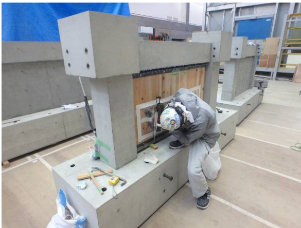
写真 2.3.3-2 あと施工アンカーとグラウト充填の施工
