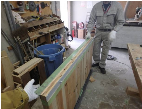
写真 2.3.3-1 CLT と山形鋼の接着施工
