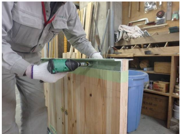
写真 2.3.3-1 CLT と山形鋼の接着施工
