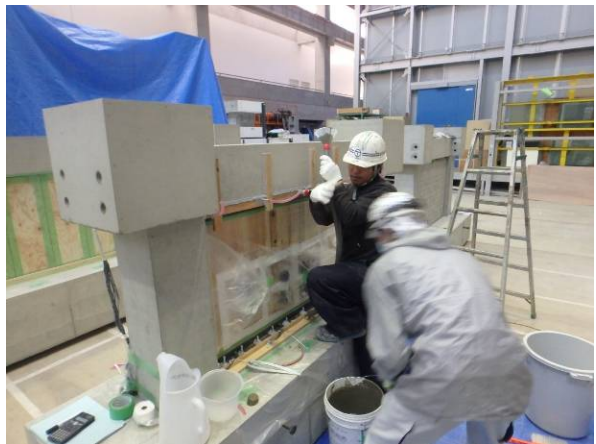
写真 2.3.3-2 あと施工アンカーとグラウト充填の施工
